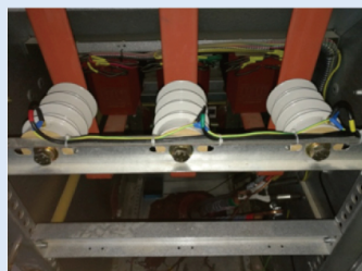
CGQ-12电容耦合传感器现场安装图
